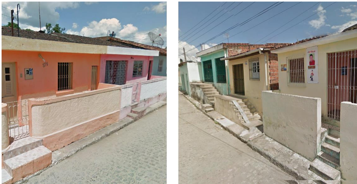
Figura 7 - Casas construídas acima do greide da rua, localizadas em regiões de alto risco
