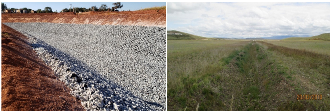
Figura 2 - Canal com geocélula GS-15 preenchido com pedra (esquerda) e solo e vegetação (direita).
