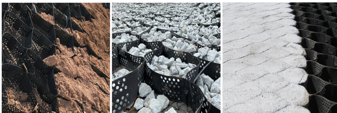
Figura 3 - Geocélulas preenchidas com solo, brita e concreto
