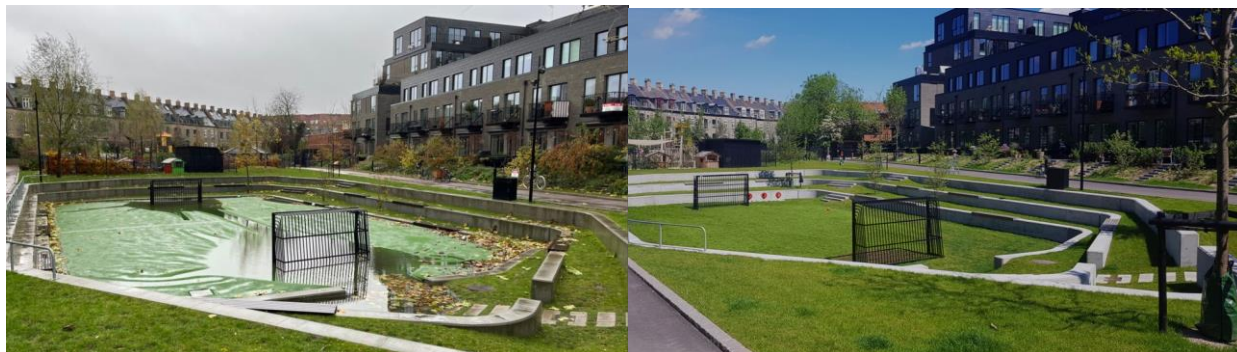
Figura 2 – Campo de futebol adaptado como bacia de retenção. Fonte: Ireland Construction News (2024)
