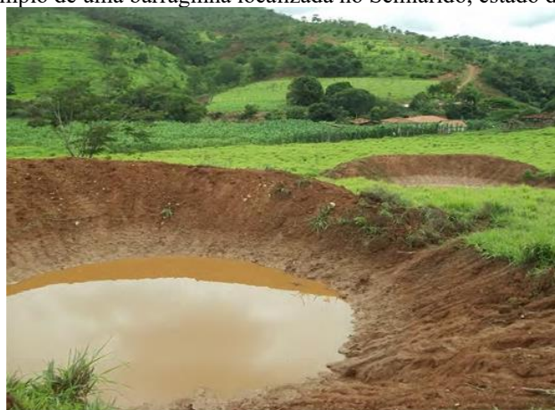
Figura 1 - Exemplo de uma barraginha localizada no Semiárido, estado de Minas Gerais.
