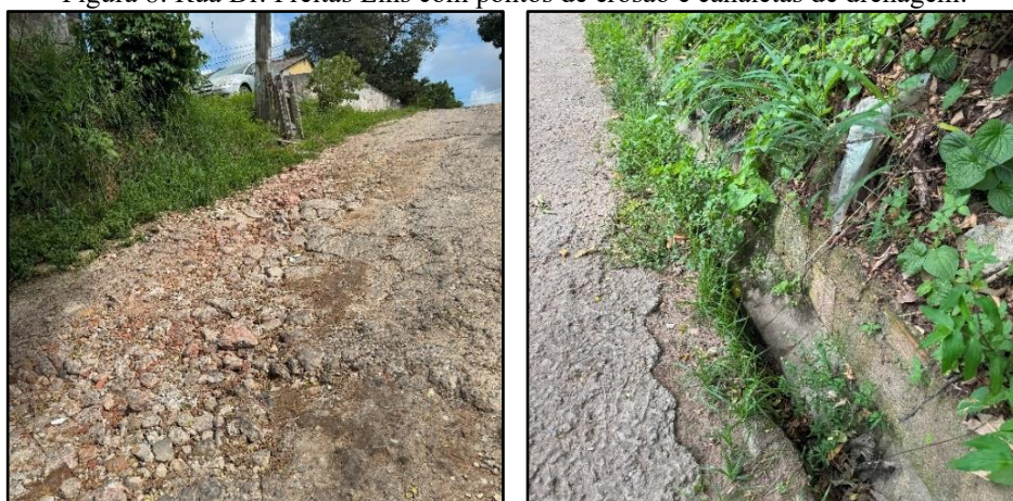
Figura 8: Rua Dr. Freitas Lins com pontos de erosão e canaletas de drenagem.
