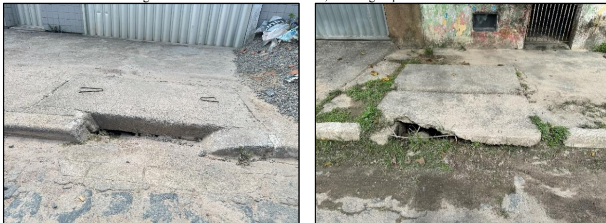
Figura 6: Caixas coletoras obstruídas, com vegetação e danificadas.
