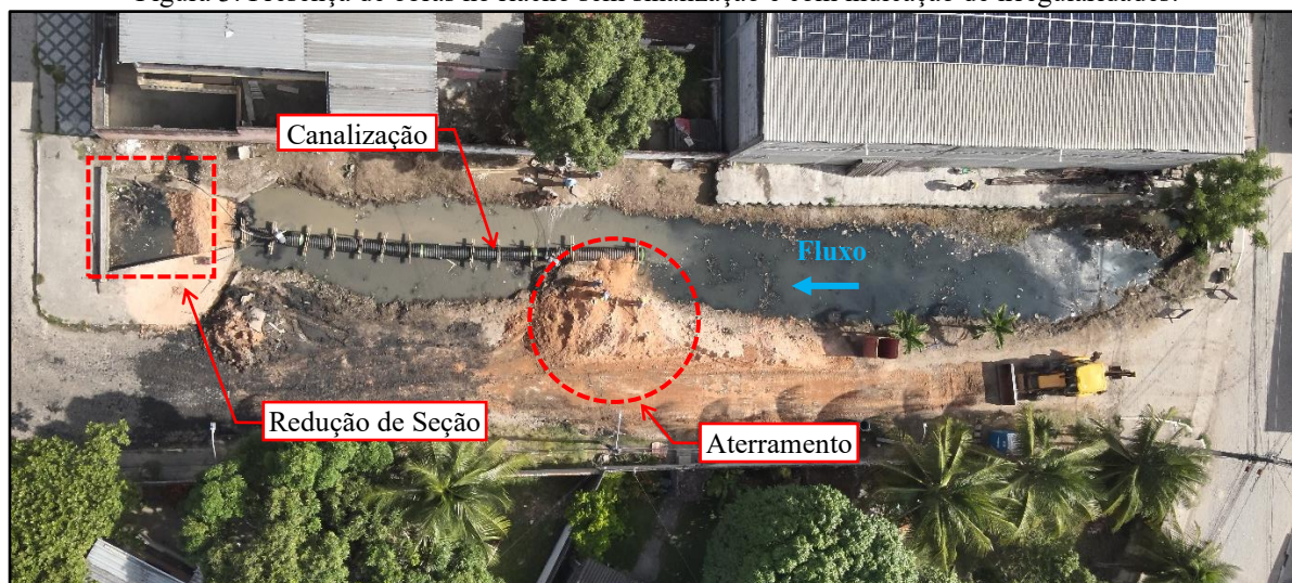
Figura 3: Presença de obras no riacho sem sinalização e com indicação de irregularidades.
