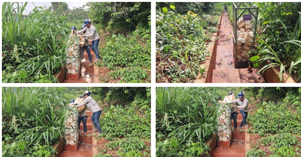
Figura 2: Instalação do tratamento químico a montante da estrutura de controle de sedimentos.
