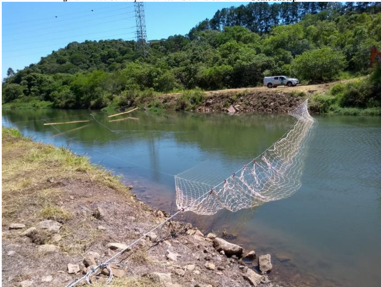
Figura 2: Rede Contenção Detritos – Sistema Cantareira. Fonte Sabesp
