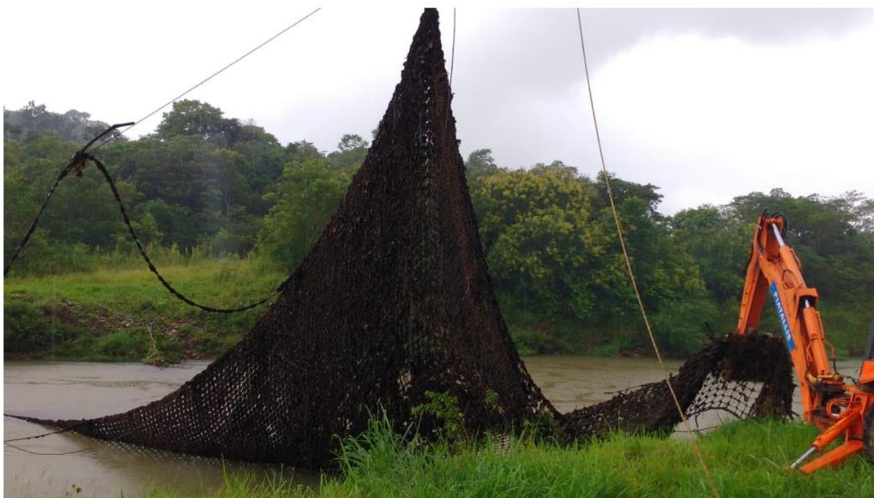
Figura 4: Rede Contenção Detritos – Sistema Cantareira. Fonte Sabesp
