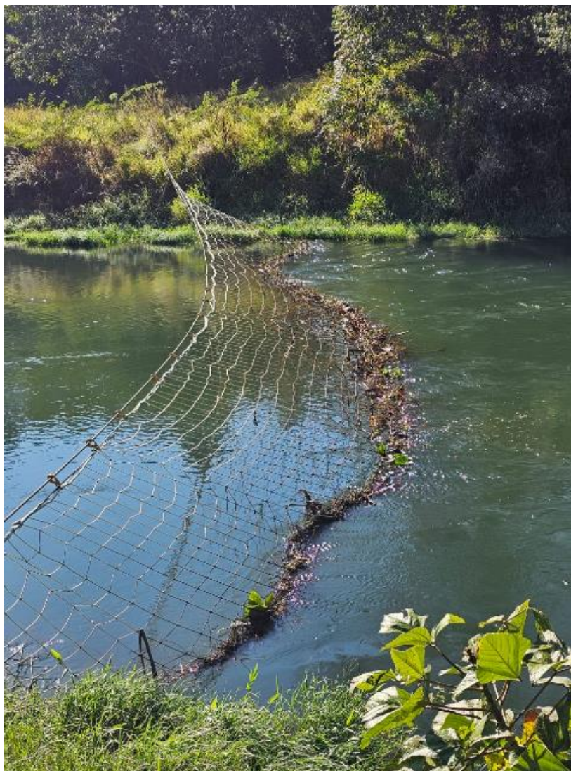
Figura 1: Rede Contenção Detritos – Sistema Cantareira. Fonte Sabesp
