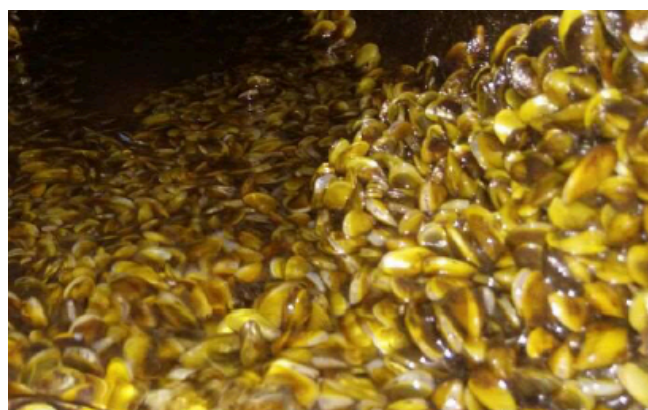
Figura 1 - Macro incrustações por mexilhão-dourado nas paredes do tubo por câmera endoscópica
