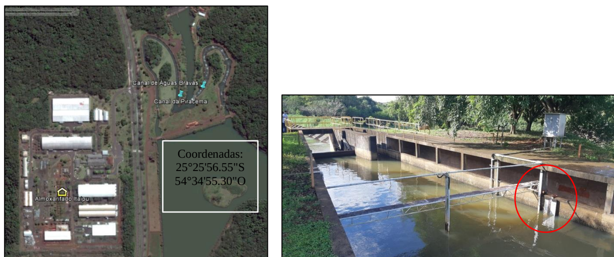
Figura 1 - a) Vista geral Canal da piracema e b) Canal de iniciação
