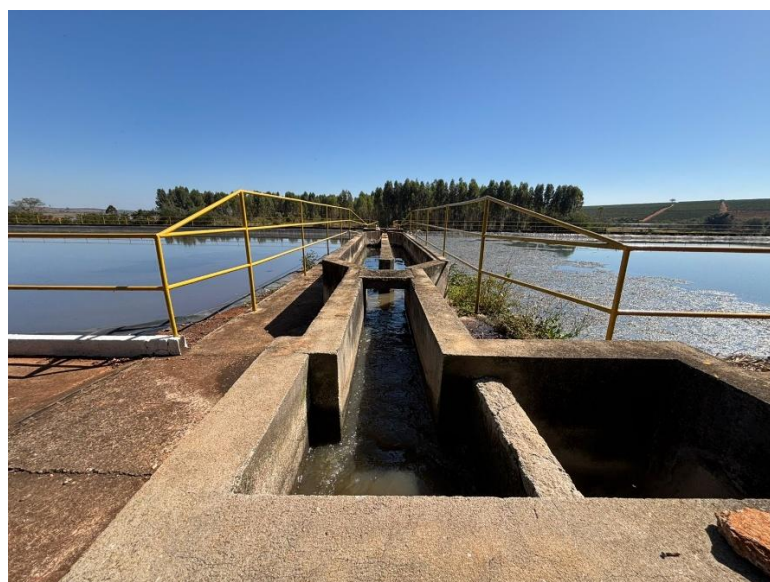
Figura 3 – Canaletas por onde chega o esgoto proveniente das estações elevatórias.
