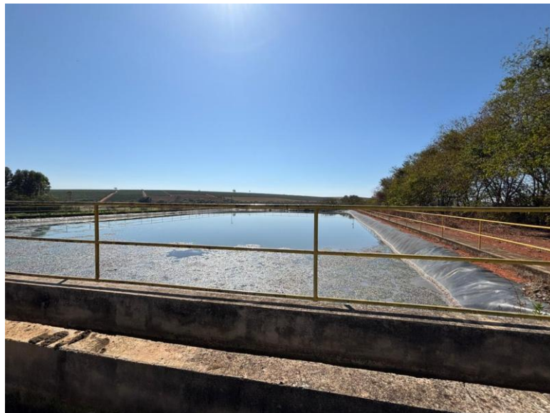
Figura 5 – Segunda lagoa de estabilização, anterior ao sistema de filtragem nas wetlands.
