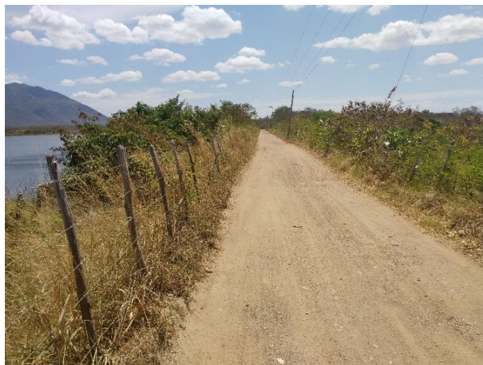
Figura 4 – Crista da barragem do Açude Cachoeira com árvores no talude de montante
