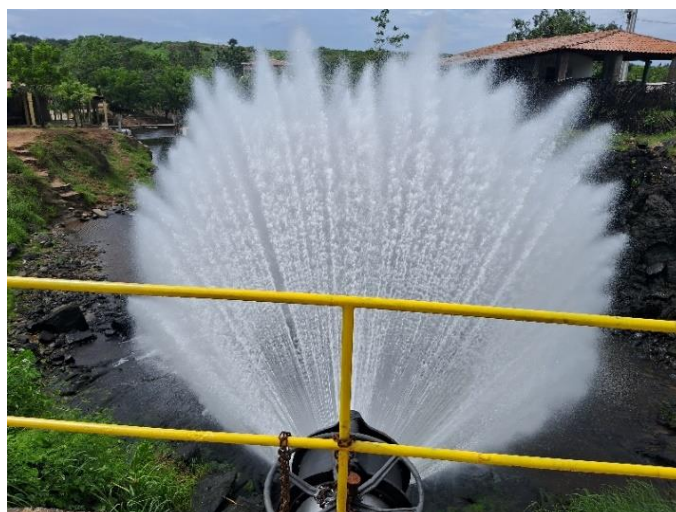
Figura 5 - Água que vem pela tomada d'água do Açude Caxitoré passando pela válvula dispersora formando o véu de noiva
