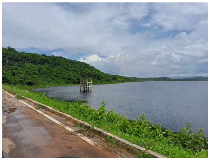
Figura 7 - Barragem onde em seu coroamento existe uma estrada com pavimento flexível
