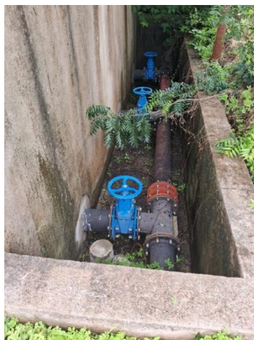
Figura 10 - Três válvulas (registros de gaveta) que liberam água que saem da casa de bombas
