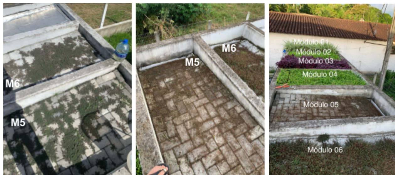
Figura 6 - M5 e M6 com vegetação daninha; M5 após manutenção; adaptação da vegetação, respectivamente.
