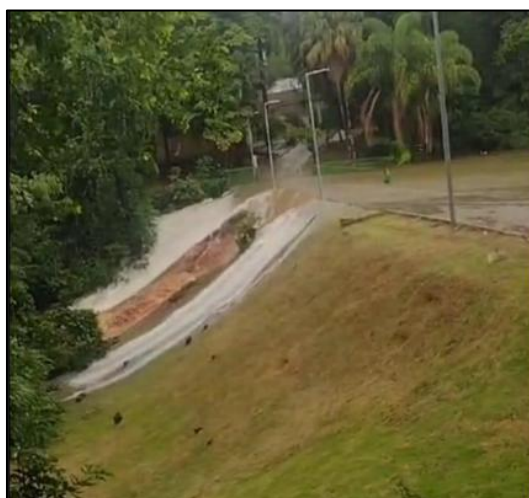
Figura 2 – Galgamento na barragem por volta das 16:00. Fonte: PBH (2024).
