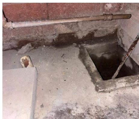
Figuras 2 e 3: Baldes inadequados para decantação e tubulações danificadas, respectivamente.
