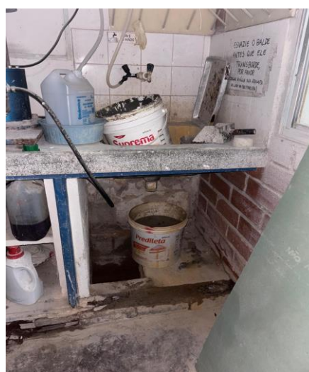
Figuras 4 e 5: Vazamento e baldes inadequados para decantação, respectivamente.
