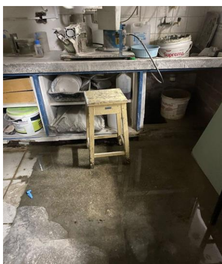
Figuras 4 e 5: Vazamento e baldes inadequados para decantação, respectivamente.
