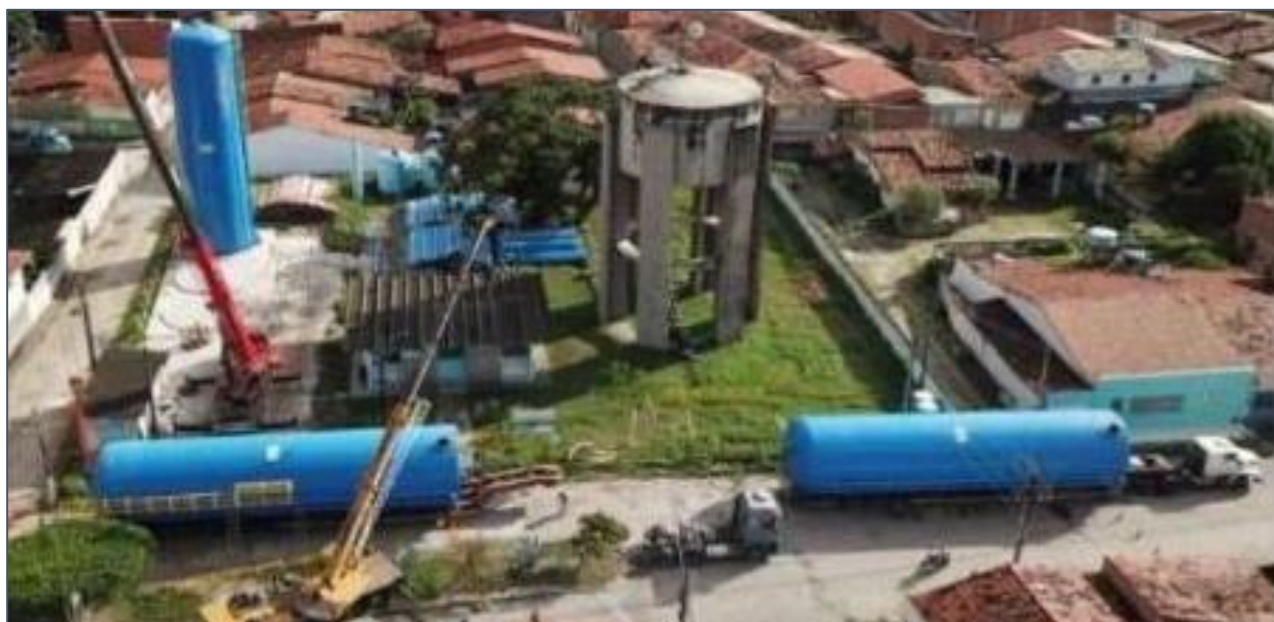
Figura 3 – Içamento dos Tanques Pulmão de PRFV
