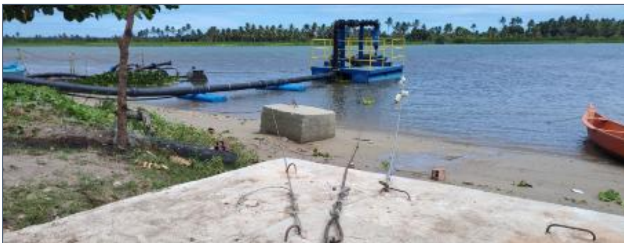
Figura 1 – Captação Flutuante e Ancoragem
