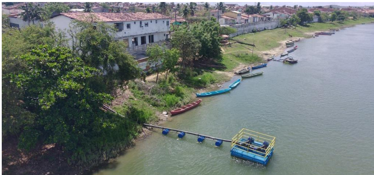
Figura 2 – Captação de Água no rio São Francisco
