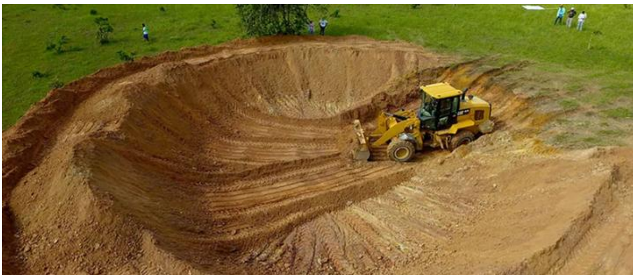
Figura 6 - Escavação de "barraginha" em São Valério - TO
