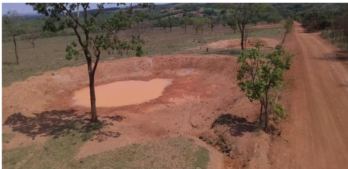
Figura 10 – “Barraginha” circular utilizada para infiltração de água e contenção de sólidos em estradas vicinais.
