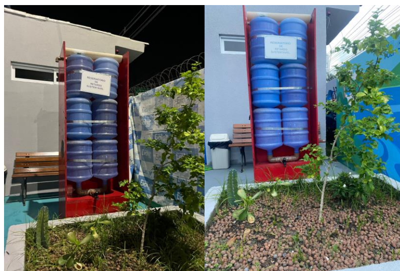
Figura 5 – Protótipo físico do sistema de captação e armazenamento de água da chuva
