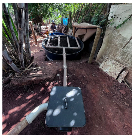
Figura 6 – Sistema de tratamento de água cinza construído (Autores, 2025)
