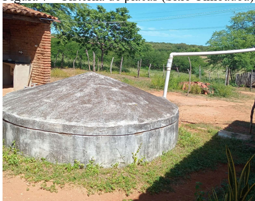
Figura 7 - Cisterna de placas (Sítio Timbaúba).
