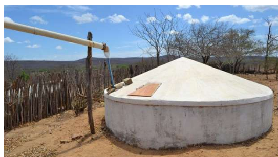
Figura 2 – Cisterna de placas com capacidade de 16mil litros
