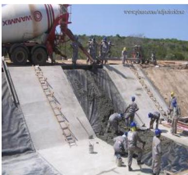
Figura 2 - Concretagem do Canal
