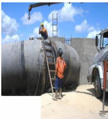
Figura 05 Tubulação dos Sifões do Canal
