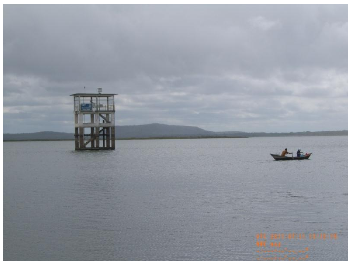
Figura 1: Tomada d'água do reservatório Poço da Cruz
