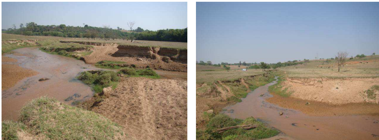
Figura 6 e 7 – Foz do córrego do Embirí e trecho à jusante - em ambos casos cursos d'água assoreados e com ausência total de mata ciliar.
