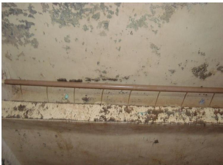
Figura 5 – Mictório tipo calha em funcionamento na Escola (B)
