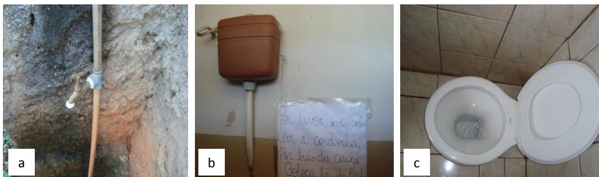
Figura 10 – a) vazamento em torneira de pátio; b) caixa de descarga danificada e com vazamento; c) bacia sanitária com vazamento.
