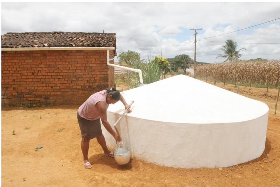
Figura 1 – Cisterna de Placas em funcionamento
