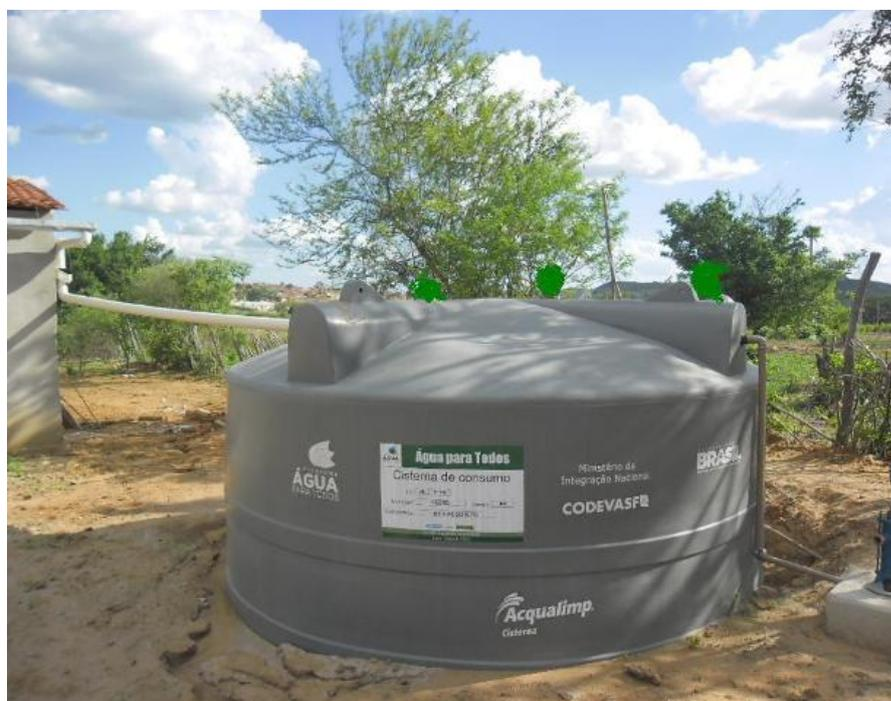
Figura 3 – Cisterna de Polietileno distribuída pelo programa Água para Todos
