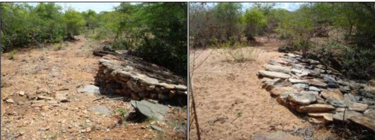
Figura 18 – Vista do barramento CD6 durante sua construção (esquerda) e na última visita (direita).
