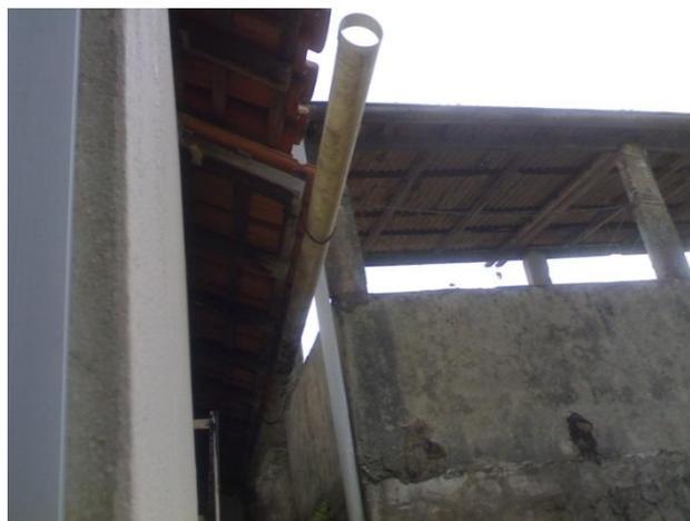
Figura 2 - Calha de PVC
