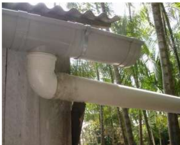
Figura 2 – Componentes dos sistemas de captação: calha
