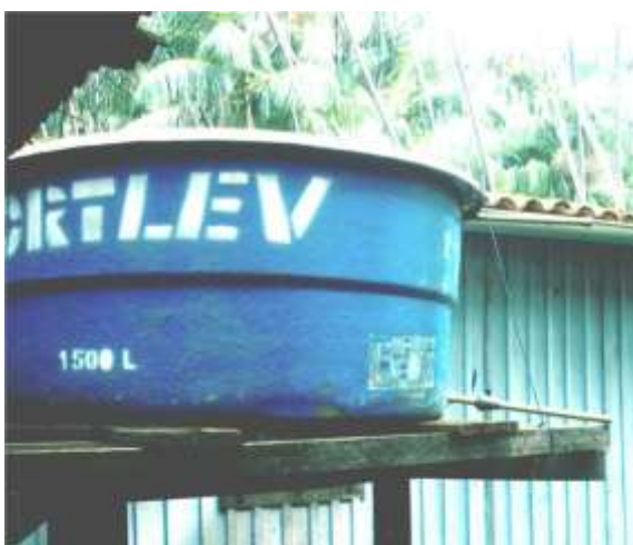
Figura 3 – Componentes dos sistemas de captação: reservatório
