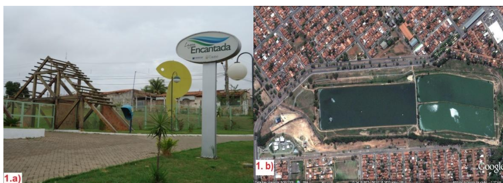
Figura 1 - a) Entrada da ETE Lagoa Encantada; b) Vista aérea da ETE.
