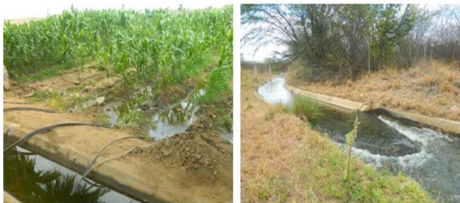
Figura 2 - Canal de Irrigação do Perímetro de Irrigação de Cruzeta no Município de Cruzeta, Rio Grande do Norte.
