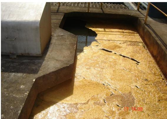
Figura 1: Tanque de Floculação
