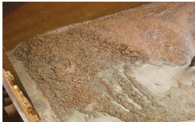
Figura 3: Lodo acumulado no decantador.
