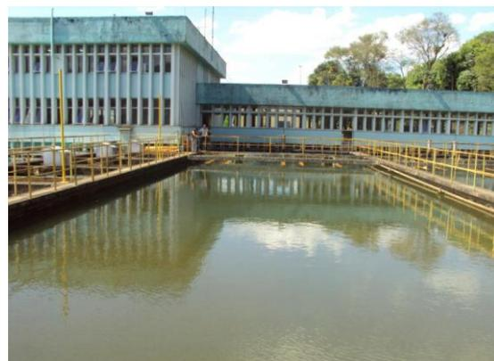
Figura 2: Tanque de Decantação.
