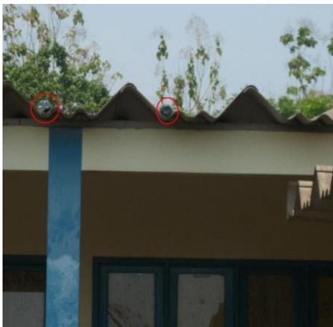
Figura 4 – Garrafas expostas ao sol com inclinação de 30°.
