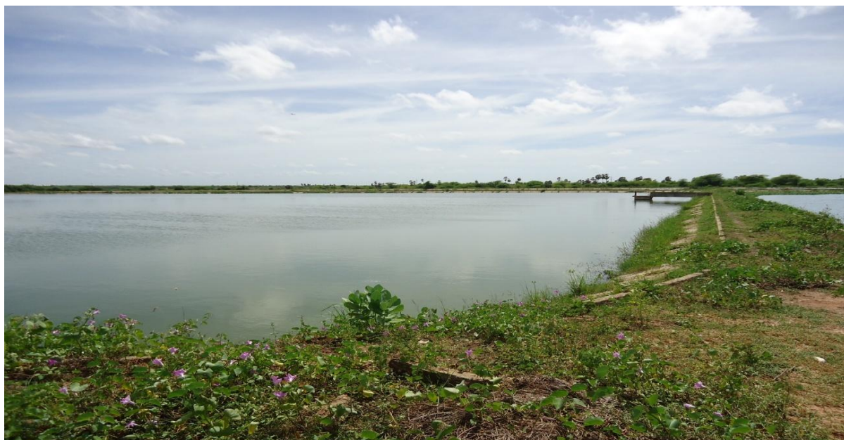
Figura 14 - Lagoa de estabilização. Fonte: Autoria própria, 2011.
