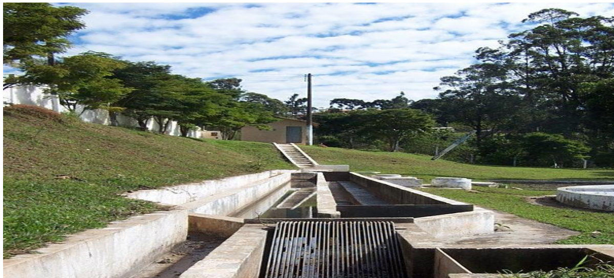
Figura 1 - Grade de limpeza manual e caixa de areia de velocidade constante. Fonte: Matos, 2001.
