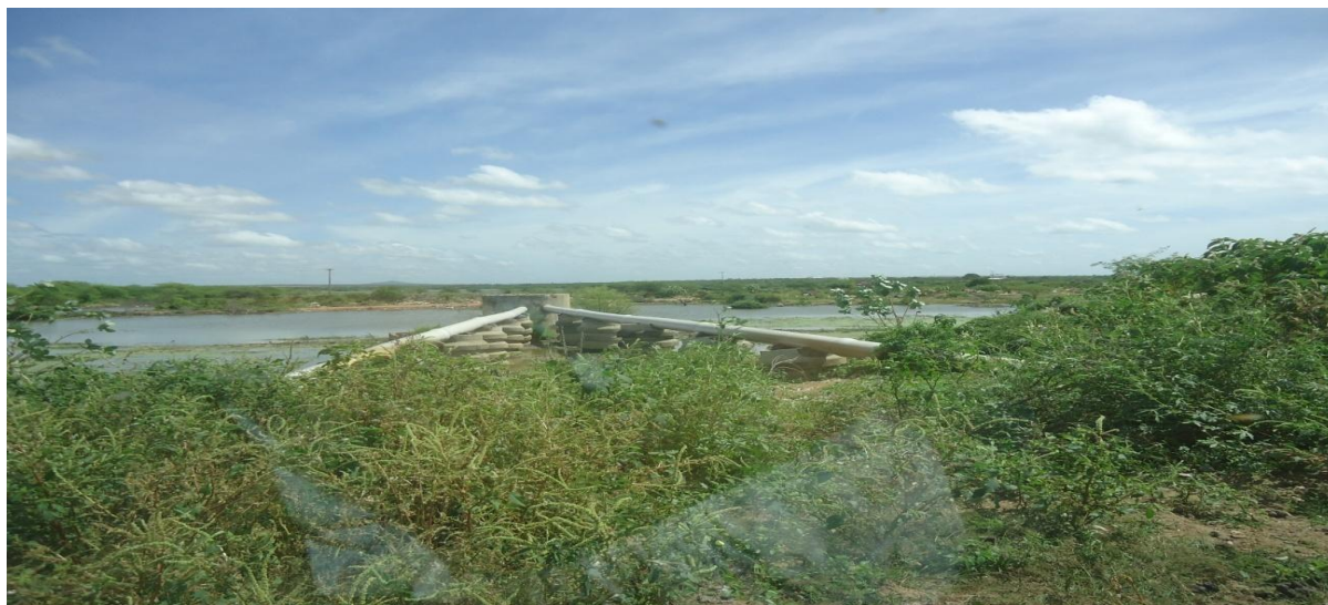
Figura 9 - Tubulações de entrada das lagoas facultativas. Fonte: Autoria própria, 2011.
