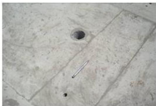
Figuras 9a e 9b – Furos ineficientes para conexão rio-aquífero no fundo e laterais da peça.
