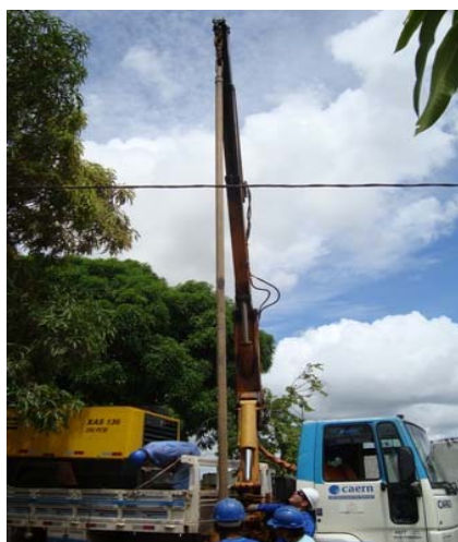
Figura 8 – Guindaste erguendo a tubulação de limpeza.
