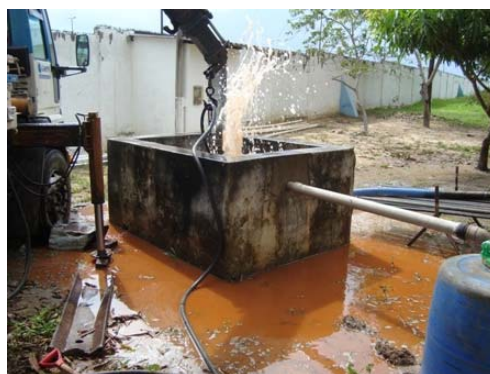
Figura 13 – Bombeamento da água ferruginosa pelo espaço anular do próprio tubo que reveste o poço e a tubulação de limpeza provisória.
