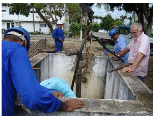
Figura 12 – Tubulação de 2\frac{1}{2} vedada para novo bombeamento.
