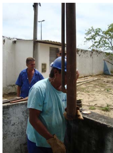
Figura 9 – Conexão das duas tubulações de limpeza.
