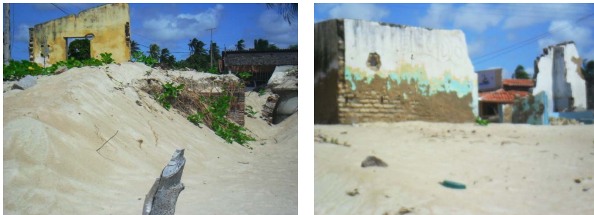
Figura 10 – Ruínas de algumas residências que foram destruídas com o avanço do mar na praia de Pititinga/RN.
