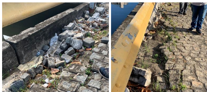
Figura 6. Exemplos de afundamentos duplos Fonte: Os autores
