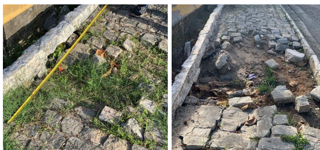
Figura 5. Exemplos de afundamentos individuais
