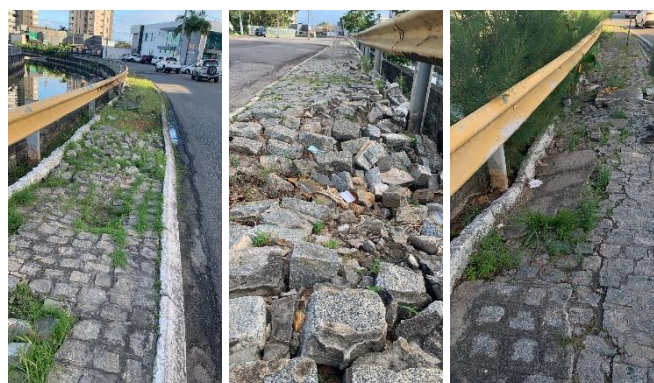
Figura 8. Exemplos de afundamentos contínuos Fonte: Os autores
