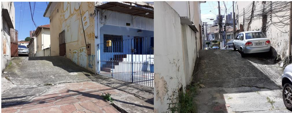
Figura 5: Dique construído no cruzamento da Avenida Água Fria com a Rua Vaz Muniz. Fonte: Elaboração própria.
