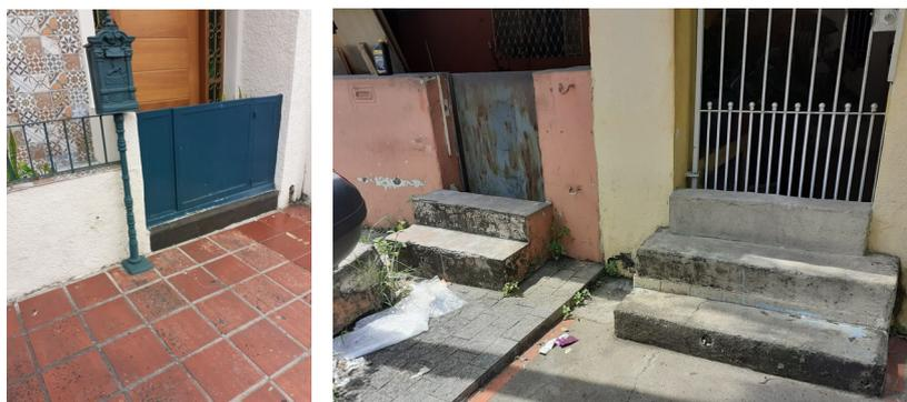
Figura 4: Comportas identificadas durante levantamentos de campo. Fonte: Elaboração própria.
