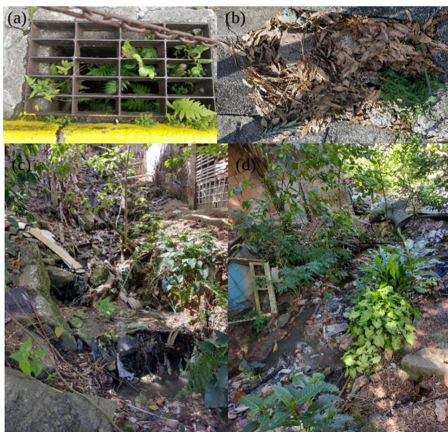
Figura 4 - (a) Bueiro com vegetação crescendo dentro; (b) Bueiro totalmente obstruído por folhas e resíduos sólidos; (c) e (d) Esgoto sanitário clandestino que são direcionados para os corpos hídricos da bacia, junto a diversos tipos de resíduos sólidos.
