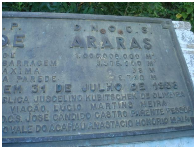
Figura 1 - Placa fixada sobre barragem com reservatório com capacidade de 1.000.000.000m 3 de água (fonte: autoria própria).
