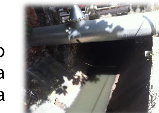
Figura 4: Estrangulamento da seção no canal
