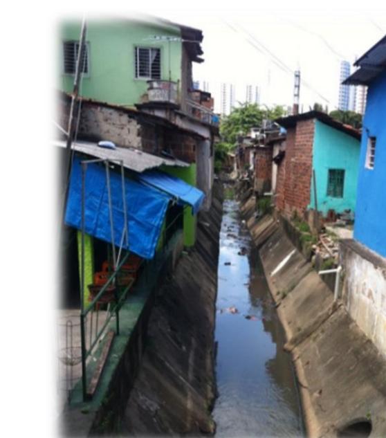
Figura 3: Ocupações Irregulares no canal
