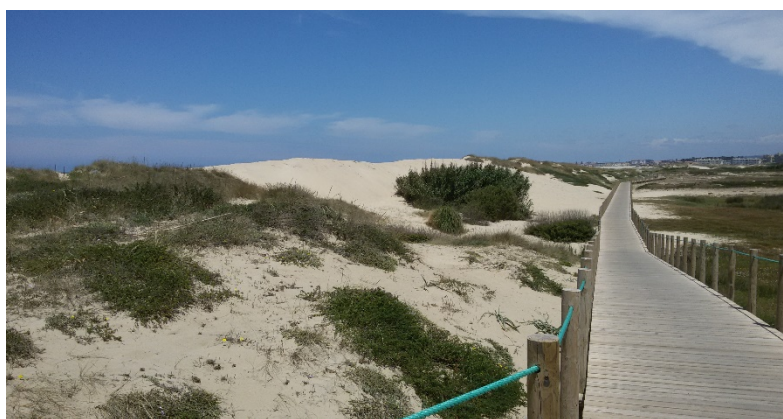
Figura1. Dezenas de quilómetros de passadiços pedonais em madeira, executados no último decénio, são utilizados intensamente pela população durante todo o ano.
