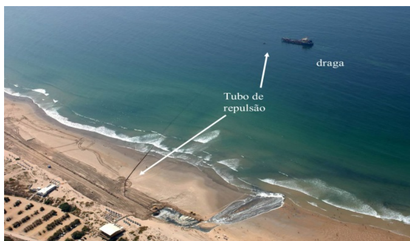
Figura 5. Alimentação artificial das praias da cidade da Costa da Caparica (a sul da foz do rio Tejo) baseada em estudos científicos e técnicos e num plano de monitorização
