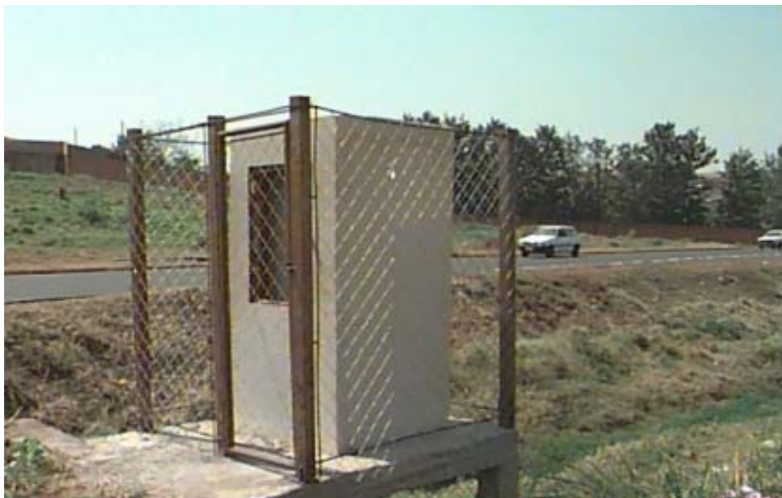
Figura 6: Estação 1 equipada com com sensor de nível d'água convencional.
