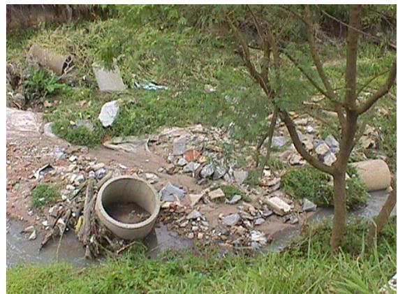
**Fig. 13 e 14.** Erosão na saída do aterro, rompimento da galeria de tubos e assoreamento do leito por restos de materiais de construção.
