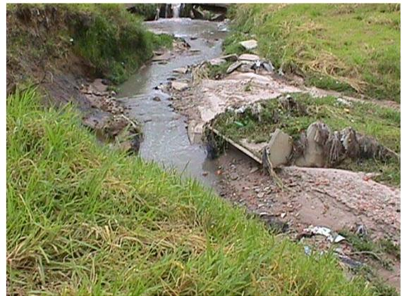
**Fig. 11 e 12.** Assoreamento do leito, obstrução por restos de obras e erosão na margem do córrego Senhorinha.
