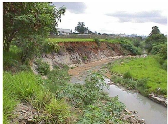
**Fig. 15 e 16.** Escorregamento de taludes e erosão das margens.
