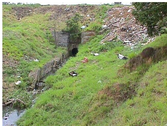
**Fig. 7. e 8.** Terraplenagem e resíduos sólidos provocam assoreamento do leito do córrego Senhorinha.
