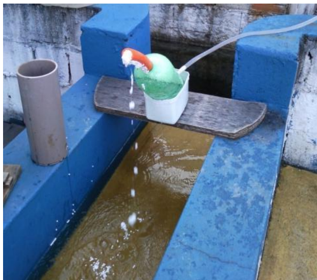
Figura 4 - Sistema de lançamento dos resíduos sólidos no canal
