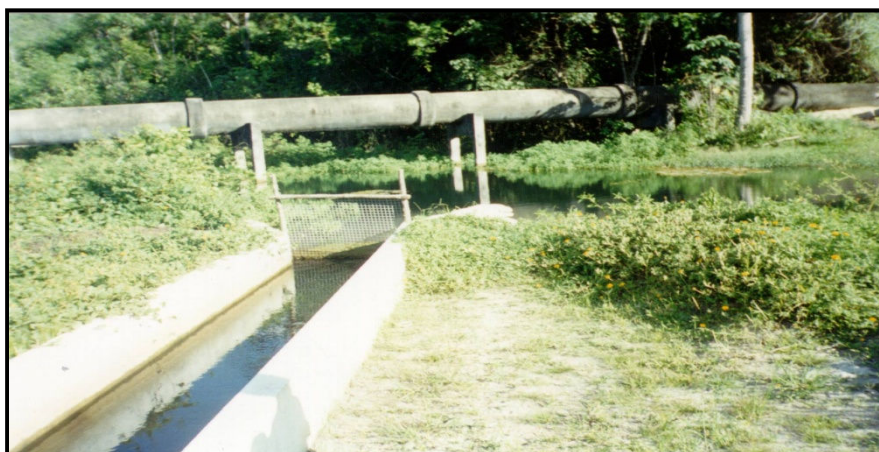
Figura 1. Canal de concreto para tomada de água – Riacho Viação.
