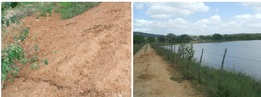
Figura 8 - Erosão nas paredes dos açudes.
