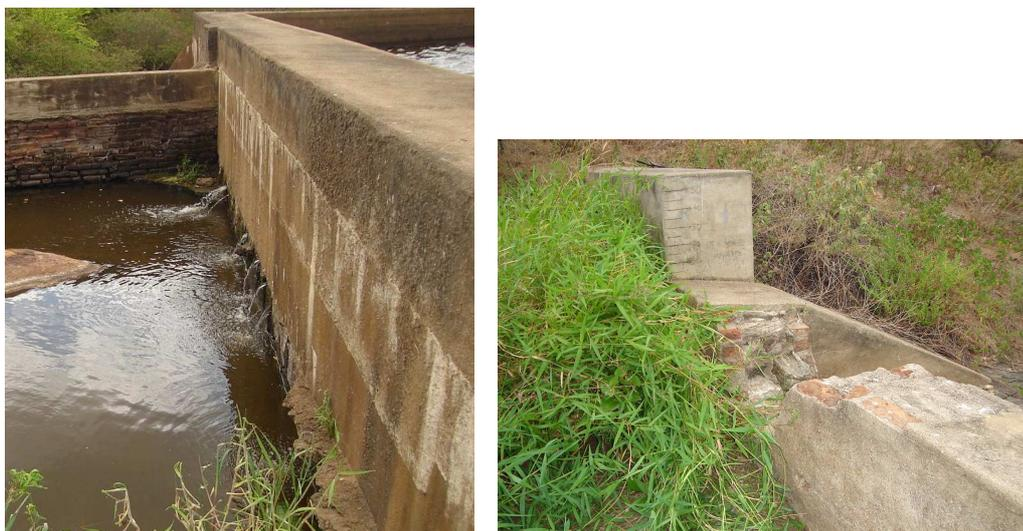
Figura16 - Sangradouros em péssimas condições de conservação.
