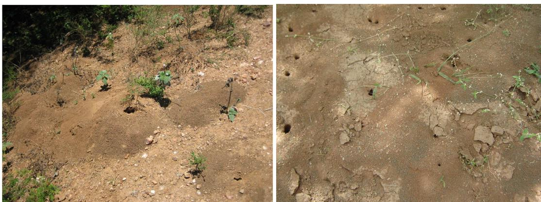
Figura 6 - Presença de formigueiros nas paredes dos açudes.
