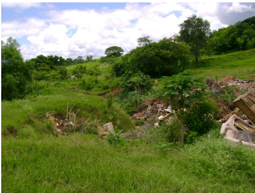
Foto 6 – Presença de entulho nas voçorocas
